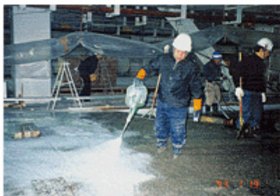
某新聞社印刷工場新築工事の例 コンクリート表面の補強改質の為に採用された。
