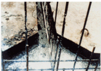
ケーソン工事例 コンクリート打ち込み後に
