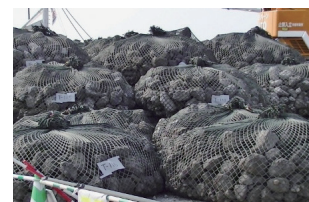
潜堤構築材（中詰材：鉄鋼スラグ水和固化体）
