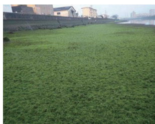
干潮時に海中から現れた広島県福山市内港のマリンストーン®敷設部。一面に海藻が生育している。
