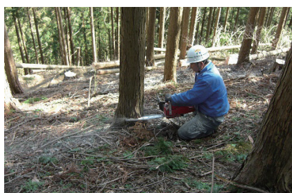
森林保全のための間伐作業の様子（山梨県）
