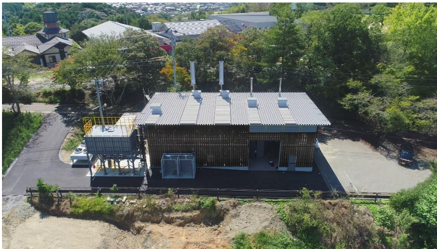
「内子龍王バイオマス発電所」外観
